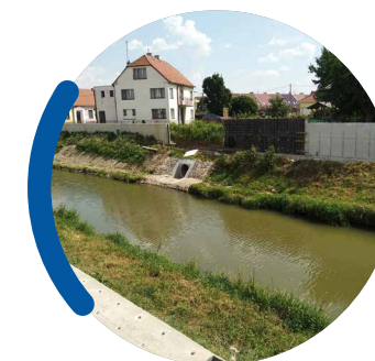
PROTIPOVODŇOVÁ OPATŘENÍ NA OLŠAVĚ
