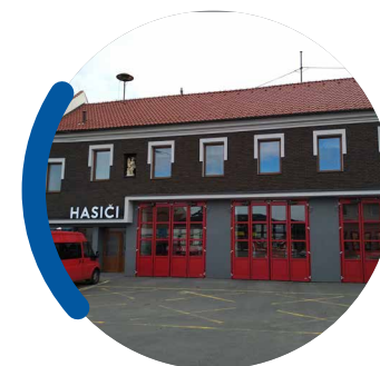
REKONSTRUKCE FASÁDY HASIČSKÉ ZBROJNICE
