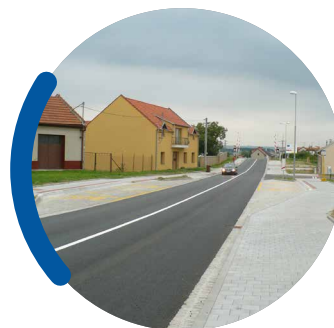
REKONSTRUKCE ULICE PANSKÁ
